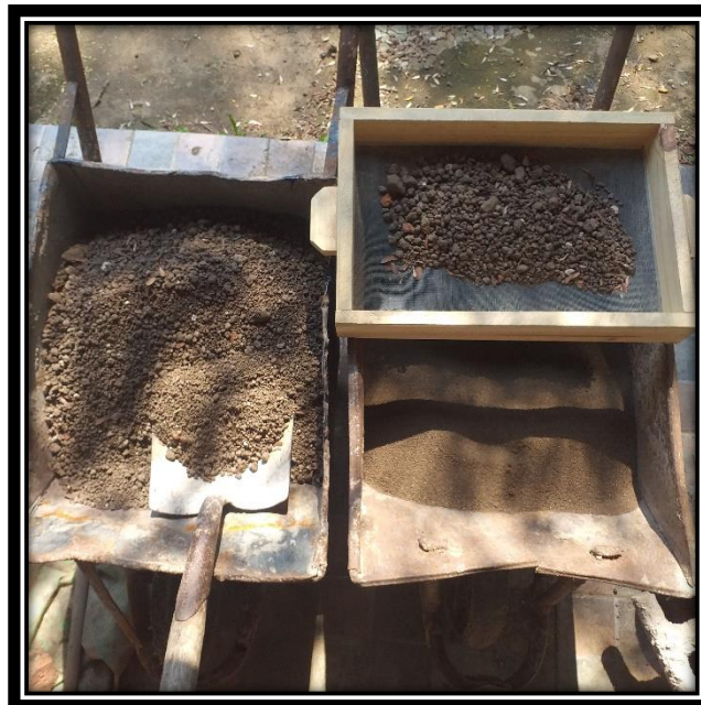
Tamizado de tierra. Fuente: elaboración propia
