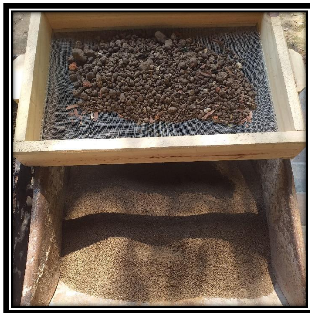
Tamizado de tierra. Fuente: elaboración propia
