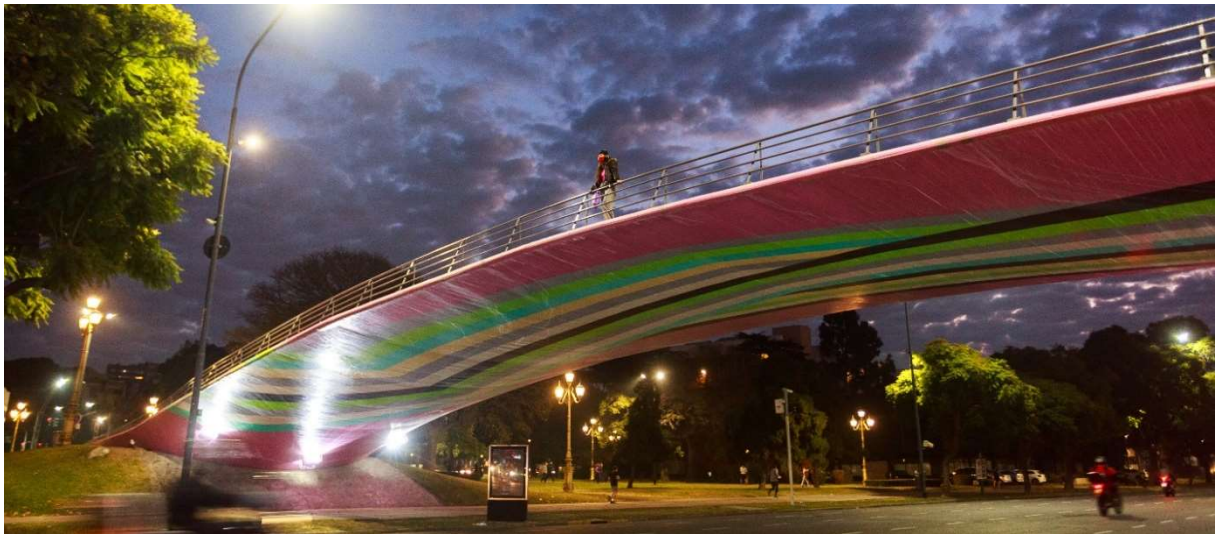
Vista del puente peatonal.
