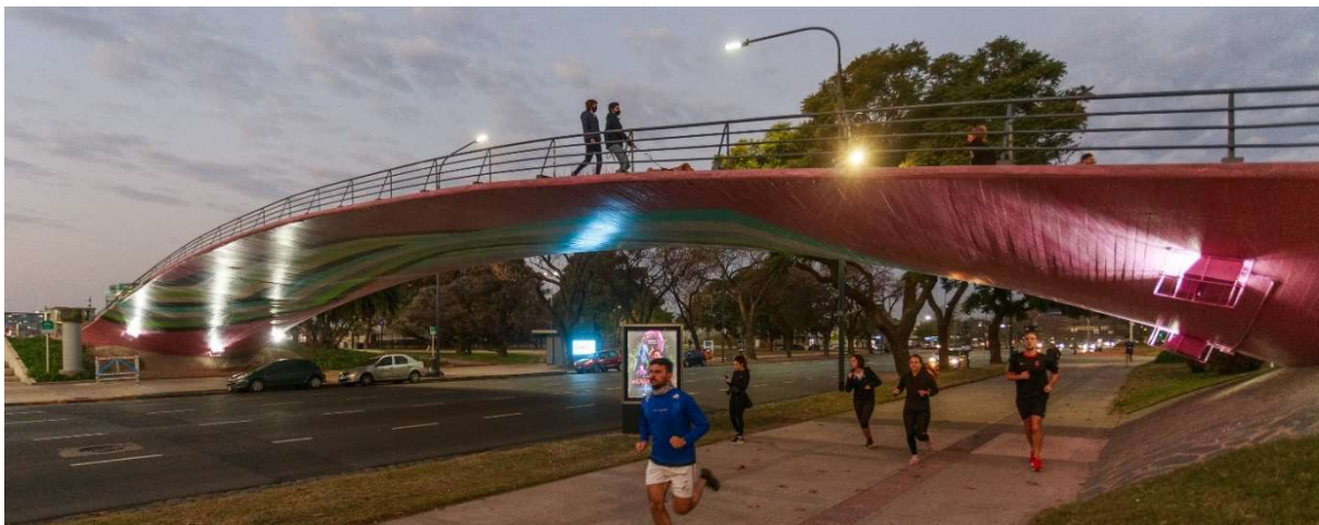
Vista del puente peatonal sobre Av. Figueroa Alcorta.
