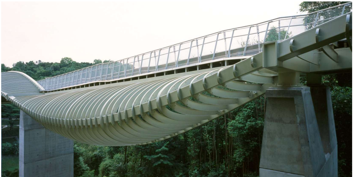
Fotografía lateral del puente.
