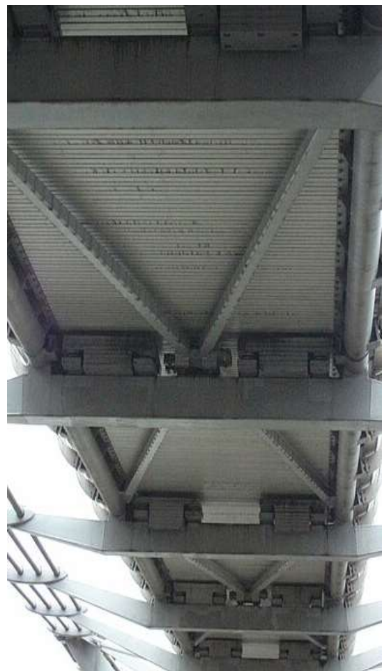
Amortiguadores en forma de V.
