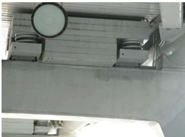
Amortiguador de masa.
