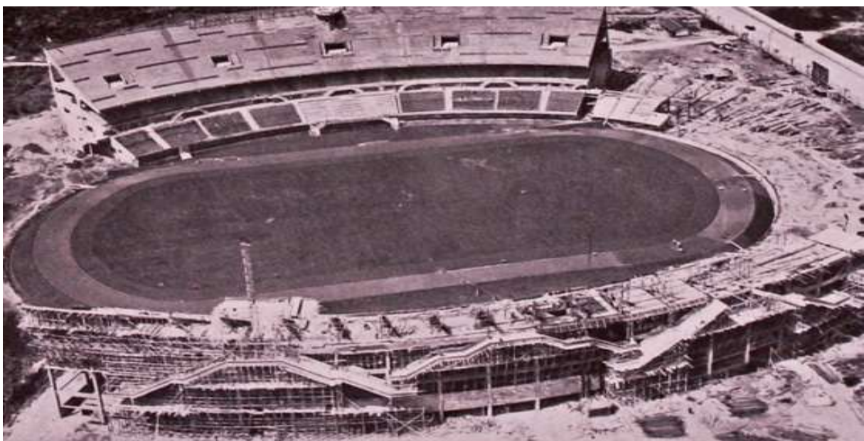
Estadio Monumental en plena construcción.
