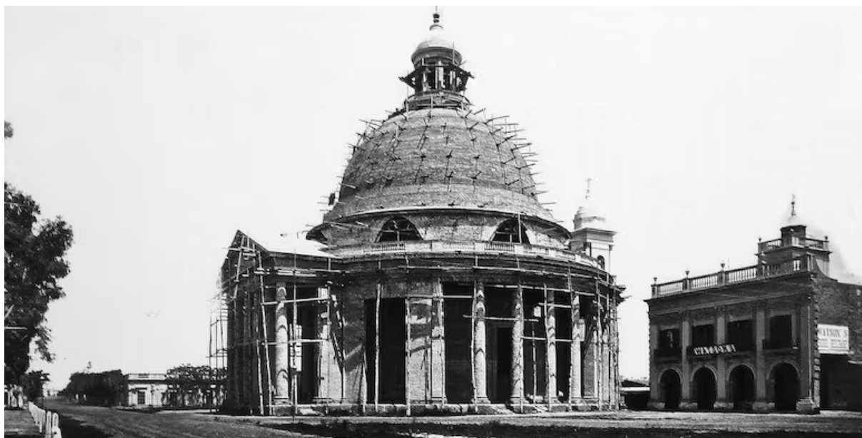
La "Iglesia Redonda" en plena construcción.
