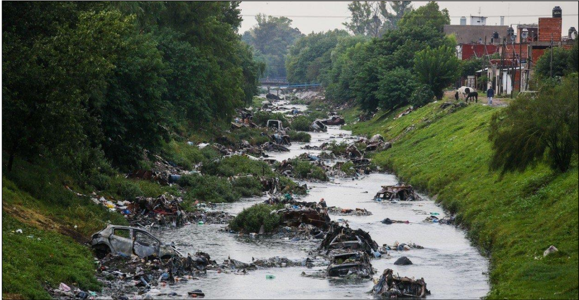
Imagen de asentamientos al borde del Río Reconquista, su caudal abarca 18 municipios de la provincia de Buenos Aires y sobre sus orillas viven 4 millones de personas en condiciones precarias.
