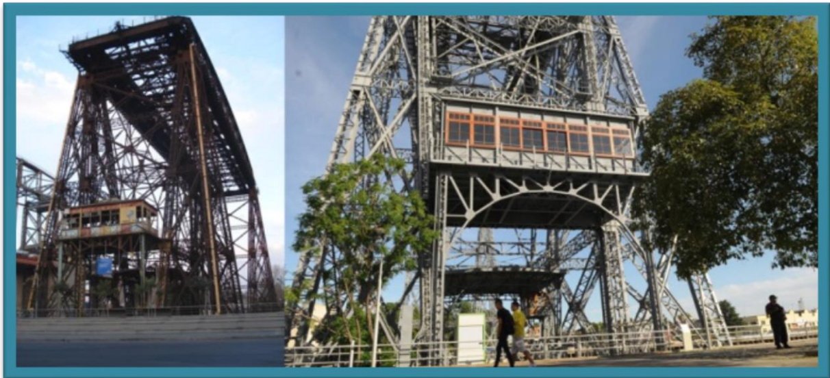
(137, 138_Sala de control y monitoreo electromecánico antes y despues de la rehabilitación.)
