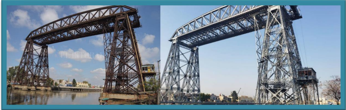
(135, 136_El antes y el después en el reacondicionamiento del Puente Transbordador.)
