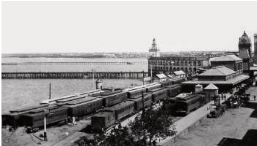
La inauguración de las obras de Puerto Madero selló el destino de los muelles. El nuevo puerto se construiría justo frente a la antigua costa. Con el avance de las obras, comenzó el desmantelamiento de aquellas estructuras que habían servido al país.
