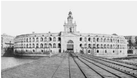
El edificio de la Aduana nueva era semicircular, con arcadas que dominaban toda su fachada a lo largo de sus dos pisos. Al frente, una torre de 20 metros de altura servía como guía para los navegantes.
