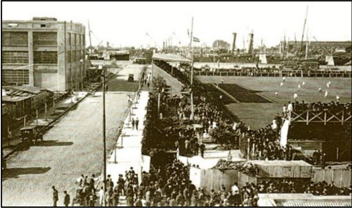
Estadio de River en Dársena Sur. Se ve la tribuna techada de Aristóbulo del Valle y la cabecera de Gaboto. El edificio de la izquierda es la primera planta industrial de Ford en la Argentina. (1938.)
