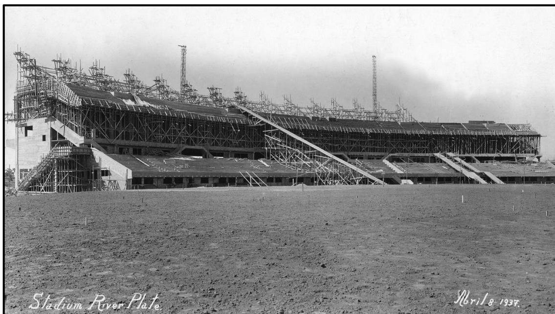
Proceso de construcción del estadio Monumental.
