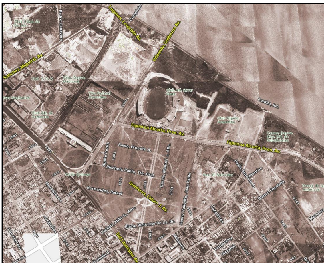
Terrenos del C.A.R.P. y alrededores, proceso de construcción del estadio Monumental.
