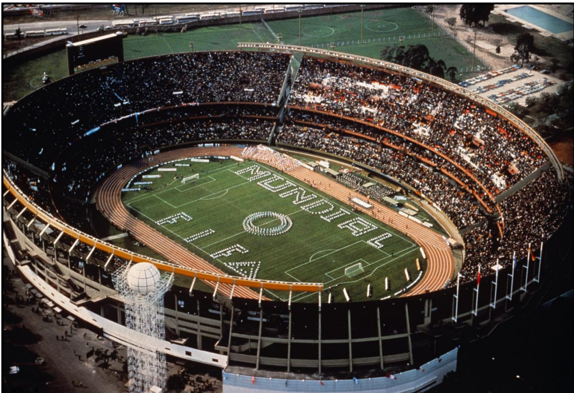
Finalización del proyecto en 1978: Completamiento de la construcción de todas sus tribunas.
