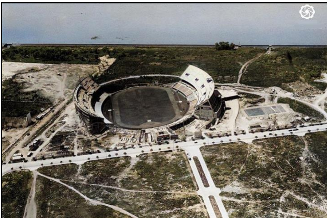
Construcción estadio "Monumental". De fondo, las orillas del Rio de La Plata (1938).
