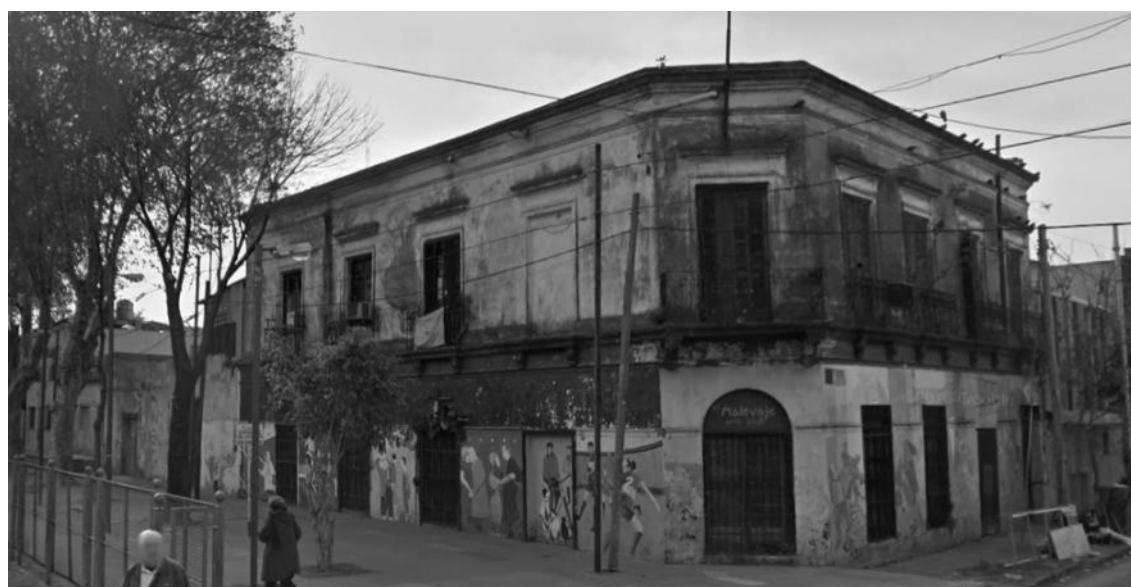
imagen 10 (esquina Quinquela Martín y Garibaldi) parcela 001r - la edificación de esquina a conservar y restaurar para uso comercial
