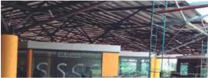
Cubierta Terminal Omnibus
